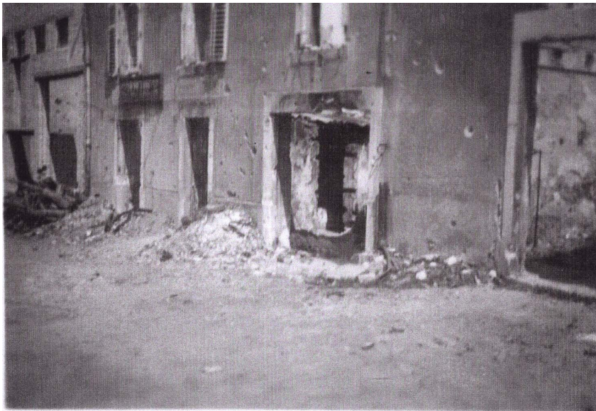
ATTON, maisons incendiées en septembre 1944 (Photo Charles Lamotte).
