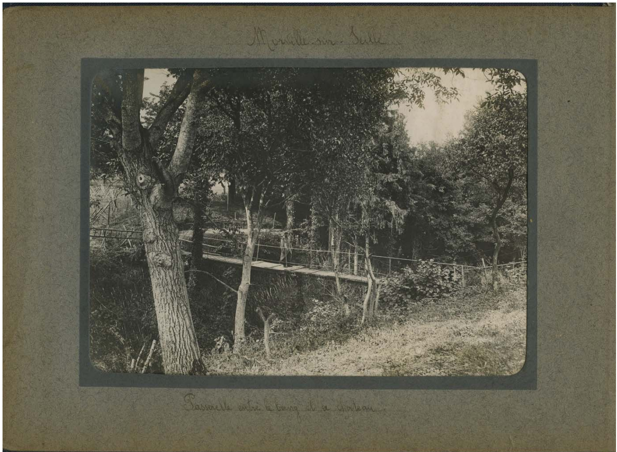
MORVILLE, passerelle entre le bourg et le chateau
